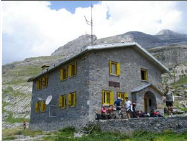
El refugio se adapta a la normativa ambiental, y se crean condiciones dignas para los trabajadores
