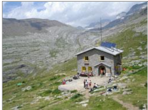
Comienzan las obras de remodelación de Góriz
